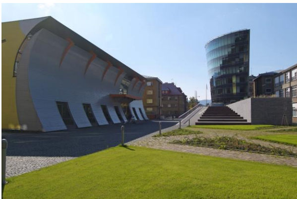
Budova Technické univerzity Liberec
